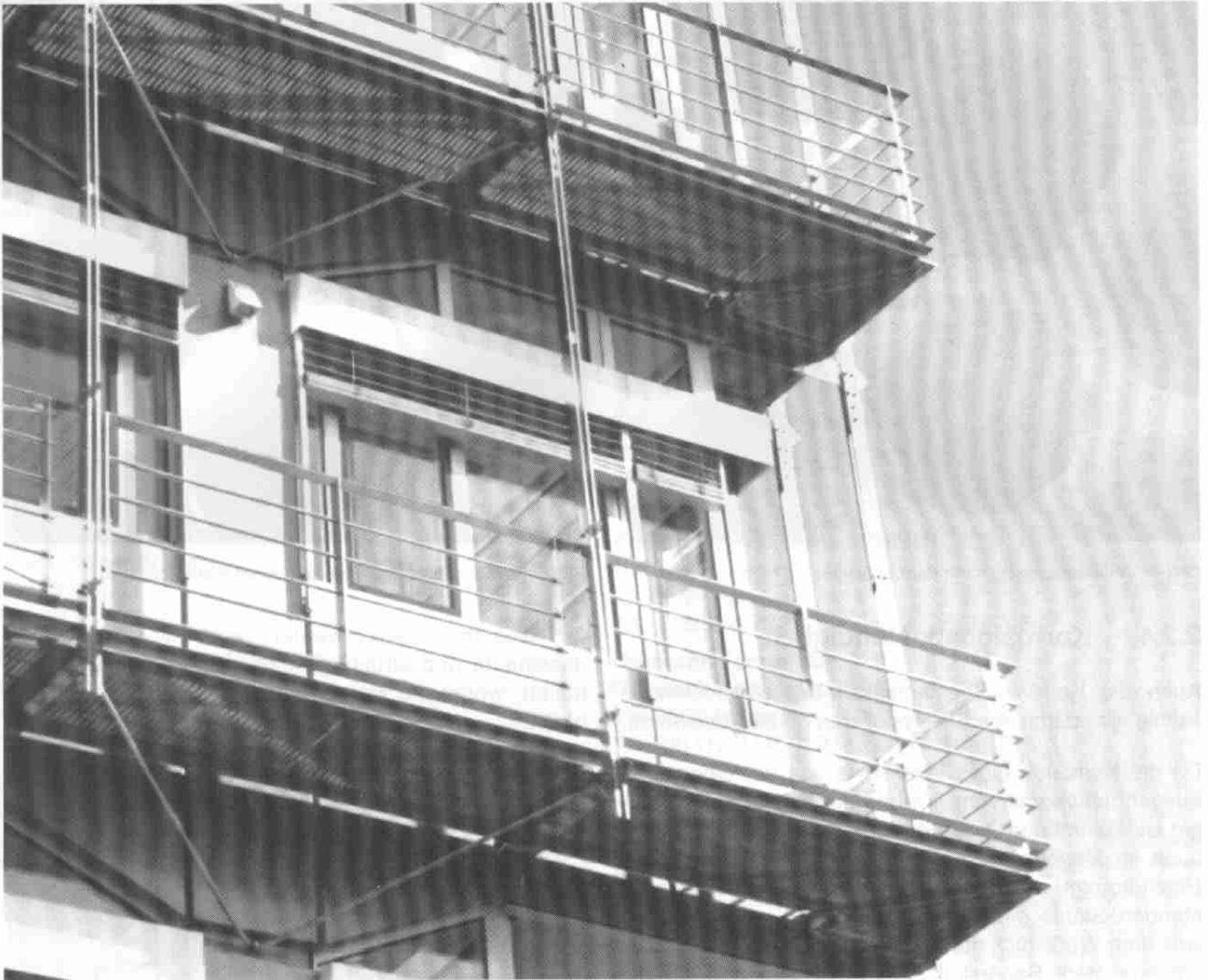
Bild 7: Balkon und Tragwerkkonstruktion aus dekorativ elektropoliertem Edelstahl Rostfrei in einem Industriegebiet mit belasteter Atmosphäre
