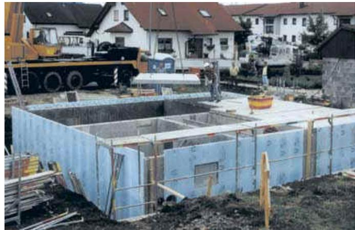
Der **ÖKO-ARCHITEKTENHAUS Komplettkeller** eignet sich hervorragend für Niedrigenergie- und Passivenergiebauten. Die ab Werk vorgefertigten Wandelemente werden mit einem patentierten Bausystem hergestellt, d.h. schon ab Werk werden verschiedene Dämmstoffe in gewünschter Stärke kraftschlüssig mit dem mineralischen Wandbaustoff verbunden. Das Ergebnis ist eine maßlich genaue, individuell vom Architekten festgelegte Kellerwandkonstruktion mit hohem Dämmwert und schneller Montagezeit.
