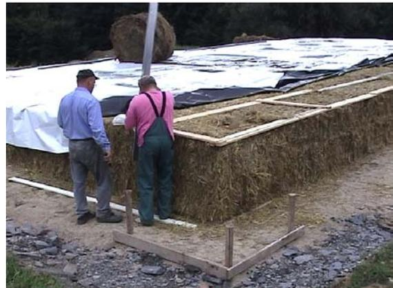
Auf einer kapilarbrechenden Schotter-schicht erweisen sich diese Strohballen als hervorragendes, 90 cm dickes Fundament. Das Mauerwerk kann ohne Zusatzbaustoffe errichtet werden und hat eine Breite von 1,25 m. Das hat nicht nur zum Vorteil, dass die Isolierungswerte immens hoch sind, sondern der Rohbau kann schnell und kostengünstig errichtet werden. Im oben gezeigten Haus wurden 95 Ballen zu je 15 Euro als Mauerwerk und Bodenplatte verbaut. Die Wohnfläche beträgt hier 105 m<sup>2</sup>.
