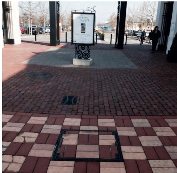
Kabelschachtabdeckung für wählbare Oberflächen, im Hintergrund Multi-top Aufsatz der ACO Tiefbau Vertrieb GmbH im Wertheim Village Outlet Center, Ingolstadt
