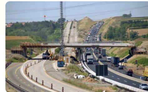
liegt. Der Überbau wurde daher überhöht hergestellt und konnte erst jetzt, mit der Verlegung des Verkehrs auf die neue Fahrbahn, abgesenkt und die B 295 über die Autobahn geführt werden.
