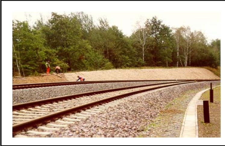
Abb. 2: Fachliches Begleiten und Überwachen der Landschaftsbauarbeiten (hier: Arbeiten zur Böschungssicherung)
