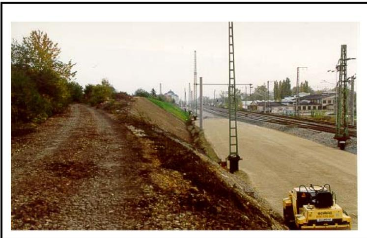
Abb. 19: Sicherung der Baugrenzen während des Bauprozesses
