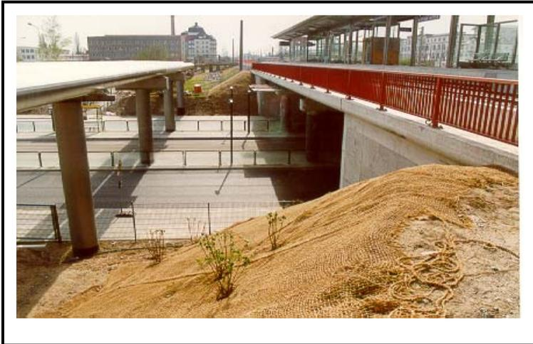
Abb. 4: Fachliches Begleiten der Arbeiten zur Sicherung einer erosionsgefährdeten Böschung (hier: Bauzustand)
