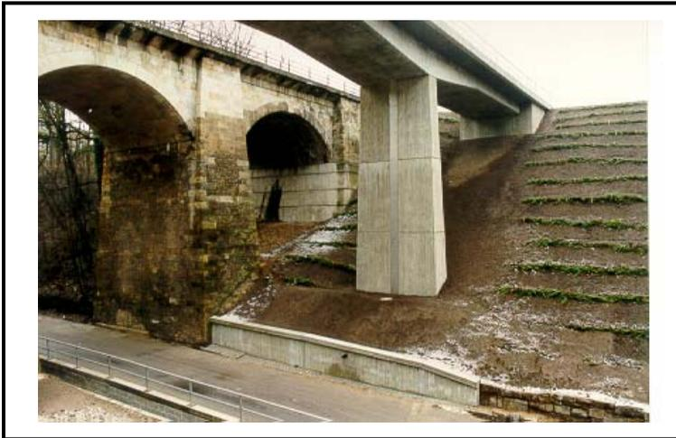
Abb. 12: Prüfen der Funktionsfähigkeit der ausgeführten Maßnahmen zur Böschungssicherung während der Fertigstellungspflege
