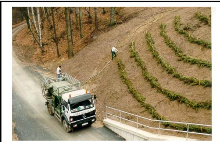
Abb. 11: Überwachen der fach- und standortgerechten Realisierung von Maßnahmen zur Sicherung erosionsgefährdeter Böschungen
