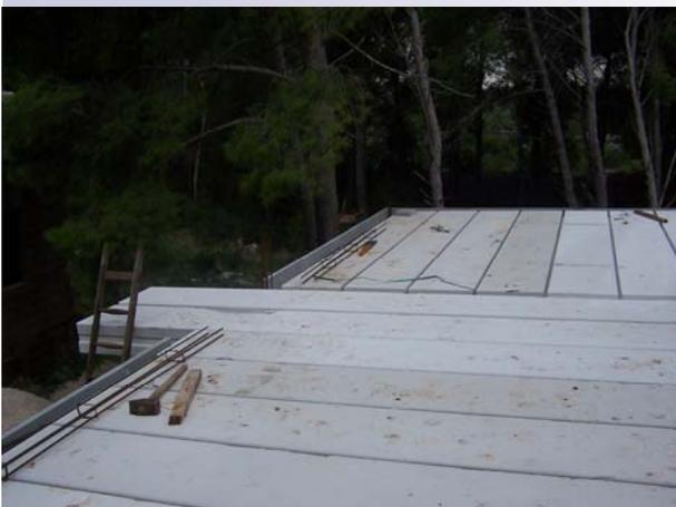
Die Zwischendecke zum Obergeschoß wurde als Fertigteilenelementdecke in Deutschland vorgefertigt.
