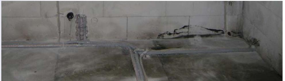
Alle WC Anlagen sind als Vorwandsystem ausgeführt worden. Die komplette Leitungsführung für eine Konvektorenheizung im Haus, ist bereits unter Putz verlegt.
