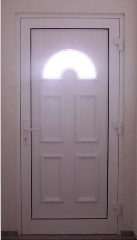
Die Eingangstüren sind in Aluminium ausgeführt und mit einer dreifach Sicherheitsverriegelung versehen.
