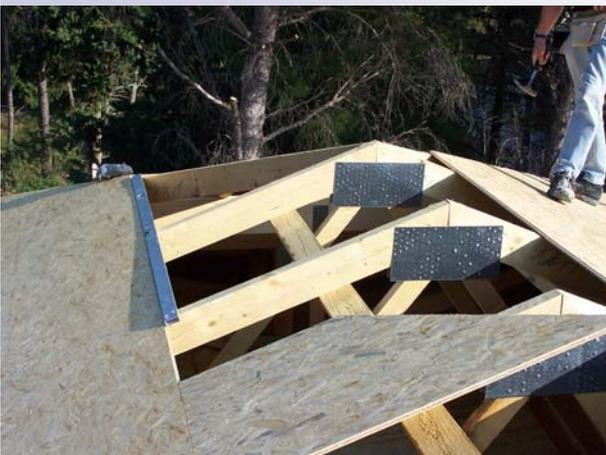
Der Dachstuhl ist komplett mit OSB Platten ausgeschalt, um so einen optimalen Schutz bei möglichen Stürmen zu gewährleisten.
