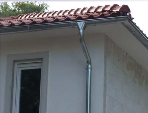
Des weiteren trägt die allseitig abgewalmte Dachform mit einem großzügigen Dachüberstand und einer konsequenten Rinnenführung an allen Gebäudeteilen zum Gebäudeschutz bei. Alle Blecharbeiten sind in reinem Zink ausgeführt worden.
