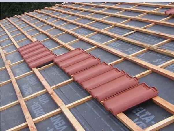
Die großformatigen Dachziegel sind geklammert und so extrem vor Sturmschäden gesichert. Um einen optimalen Schutz gegen Feuchtigkeit zu gewährleisten, ist eine diffusionsoffene aber wasserdichte Unterspannbahn eingebracht worden.
