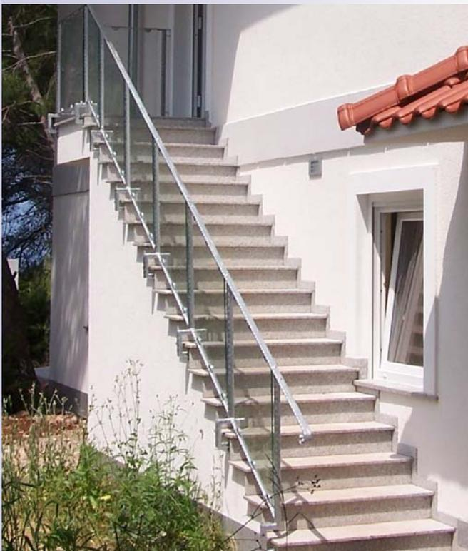
Alle Fensterbänke, aber auch die Treppe und der Fassensockel sind aus extrem widerstandsfähigem und pflegeleichtem Granit ausgeführt worden.
