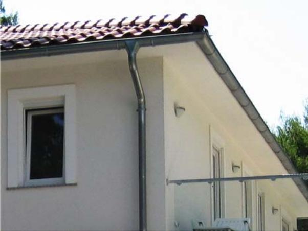
Ein weiterer großer Vorteil ist der wartungsfrei ausgeführte Dachüberstand (Silikonhartputz). Ein regelmäßiges Streichen ist nicht erforderlich, da der Dachüberstand mit dem gleichen Witterungsschutz wie die Fassade ausgestattet worden ist.
