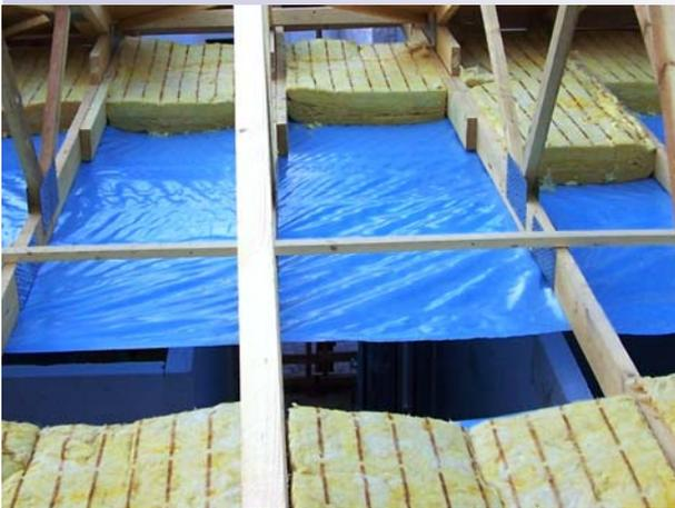
Eine Dampfsperre im Obergeschoß gewährleistet eine optimale Trockenheit in den gedämmten Bereichen. Damit ist eine Langlebigkeit der Dachkonstruktion gewährleistet.
