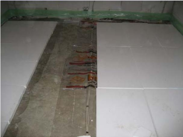
Trittschalldämmung und Wärmedämmung sorgen in allen Bereichen für ein angenehmes Raum- und Wohnklima. Auch die komplette Terrasse im ersten Obergeschoß ist mit Trittschallschutz versehen.
