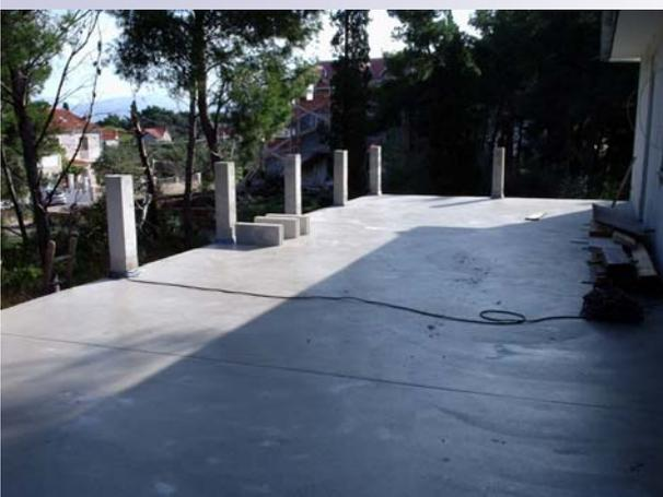
Der Zementestrich ZE 30 ist mit Flusskies aus dem Landesinneren erstellt worden. Somit ist ein auf der Insel weitläufig bestehendes Problem, „das Aufblühen der Fugen“ bei feuchter Reinigung ausgeschlossen.
